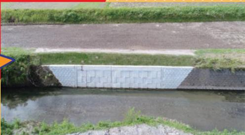
工事内容 : 野田川の護岸が28年度の大雨で被災しました。その護岸の復旧工事でした。施工箇所は3ヶ所、特殊なブロック積を使用して行いました。
