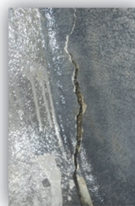
② 槽内の亀裂箇所
