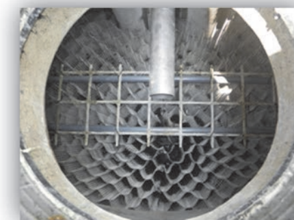
④ ろ材を戻して補強して完了
