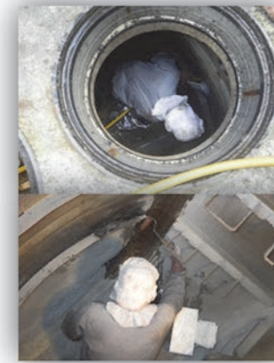
③ 槽内で作業中
