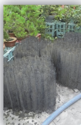
① 槽内からろ材取り出し
