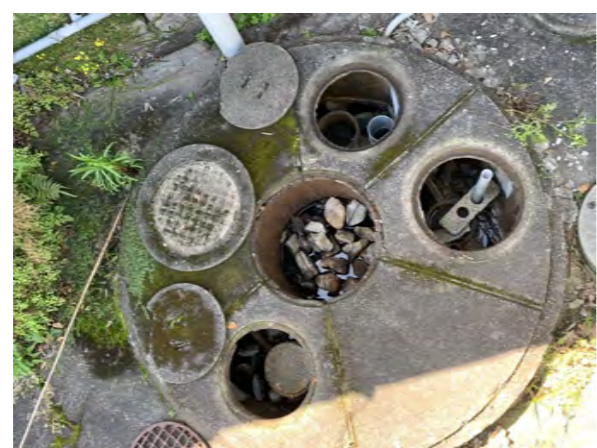
弊社で維持管理している浄化槽の中で古参の部類です(腐敗型)
