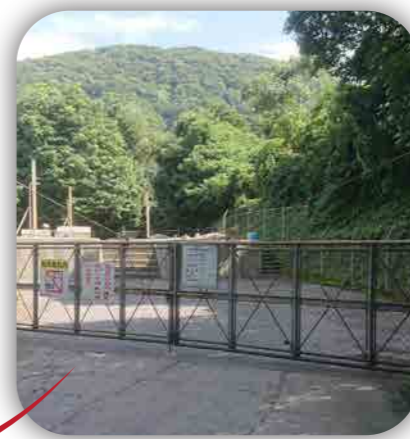
【桜島地区中継タンク】
