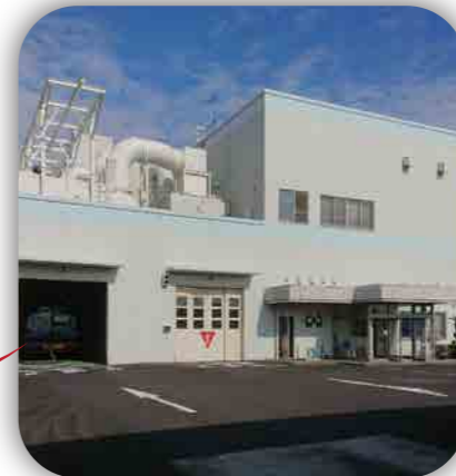
【鹿児島市衛生処理センター】
